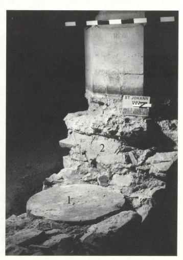
Abb. 3 Haupt der zweiten romanischen Säule von Westen (1). Im Mörtel darüber Abdruck des Kapitells (2), das bei der Anlage der äusseren Seitenschiffe 1515/17 entfernt wurde.
