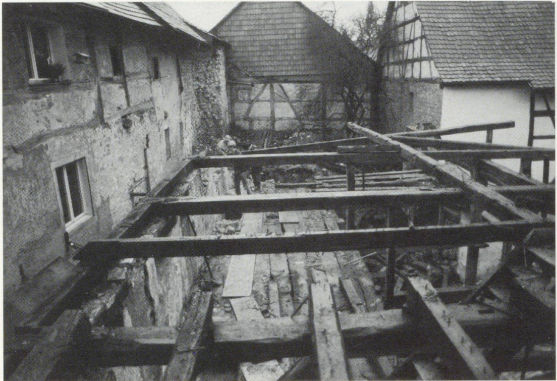
Abb. 7 Nordfassade von I und II während des Abbruchs der Trotte 1987. Links oben die Fachwerke von Bau II a und dessen Vorgängerbau.
