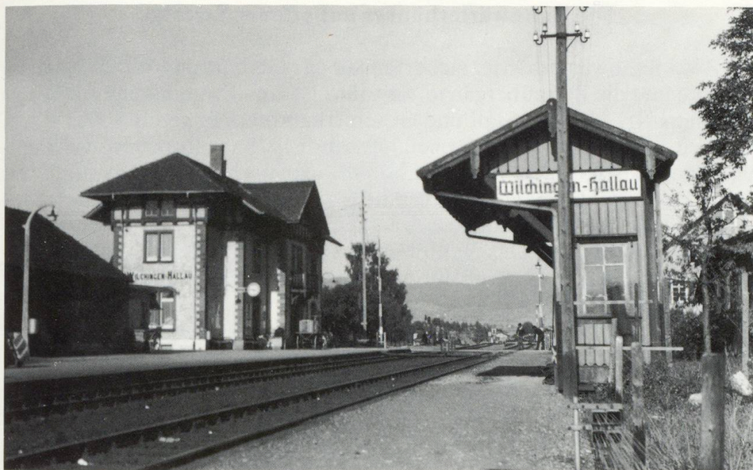
Abb. 2 Die Station Wilchingen-Hallau im Jahre 1961. Am linken Bildrand ist das «Abort- und Ökonomiegebäude» zu erkennen (abgebrochen 1971). Die «Schirmhalle» rechts im Vordergrund wurde schon 1963 abgebrochen. Aufnahme aus dem Jahre 1961 von Hermann Werner (1896–1975). (Staatsarchiv Schaffhausen)
