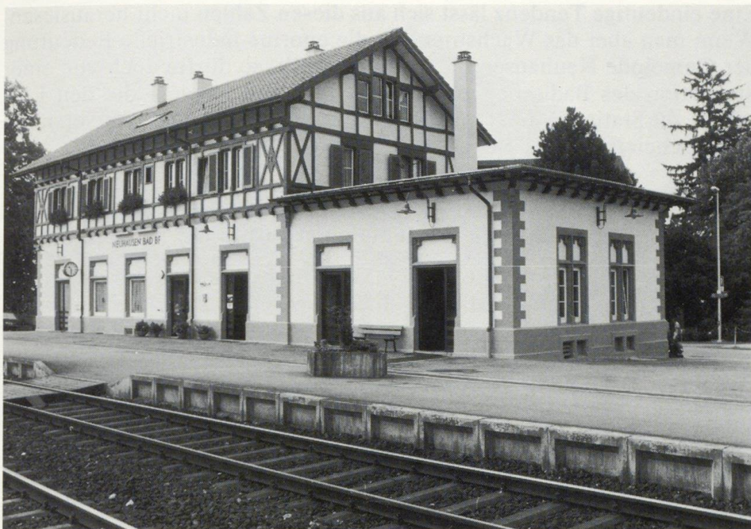
Abb. 3 Der Badische Bahnhof in Neuhausen nach der Renovation von 1985. Der eingeschossige Anbau wurde 1901 errichtet und enthält das Stellwerk.
