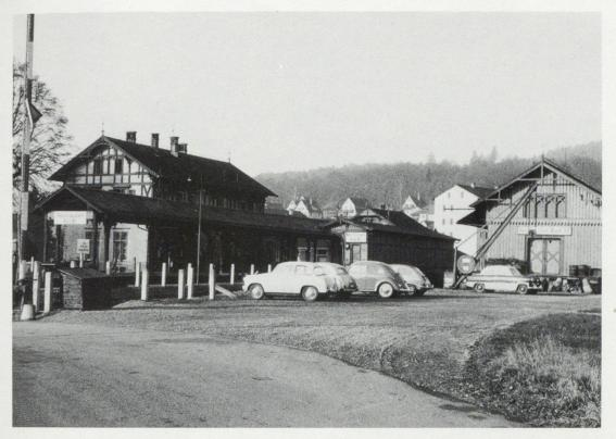
Abb. 1 So präsentierte sich der Badische Bahnhof in Neuhausen im Jahre 1958. Von links nach rechts erblickt man die Bahnschranke am Bahnübergang Ost, das Aufnahmegebäude, die «bedeckte Halle», die nördliche «Schirmhalle» und den Güterschuppen.
