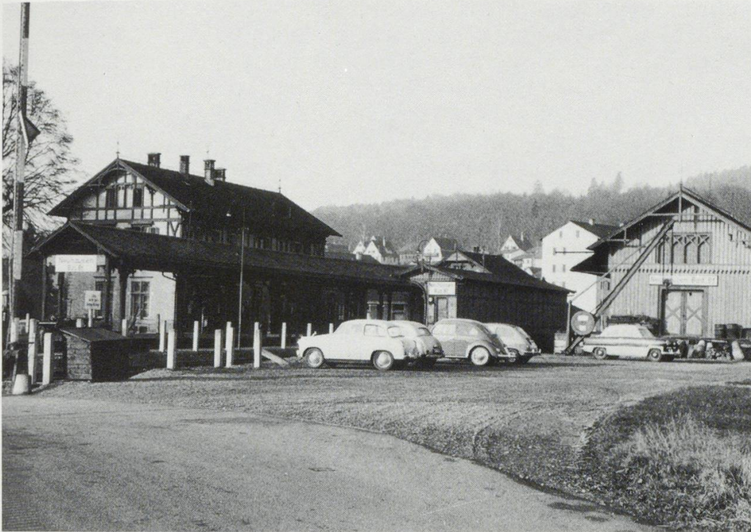
Abb. 1 So präsentierte sich der Badische Bahnhof in Neuhausen im Jahre 1958. Von links nach rechts erblickt man die Bahnschranke am Bahnübergang Ost, das Aufnahmegebäude, die «bedeckte Halle», die nördliche «Schirmhalle» und den Güterschuppen. Aufnahme: Alusuisse, Forschung und Entwicklung, Neuhausen
