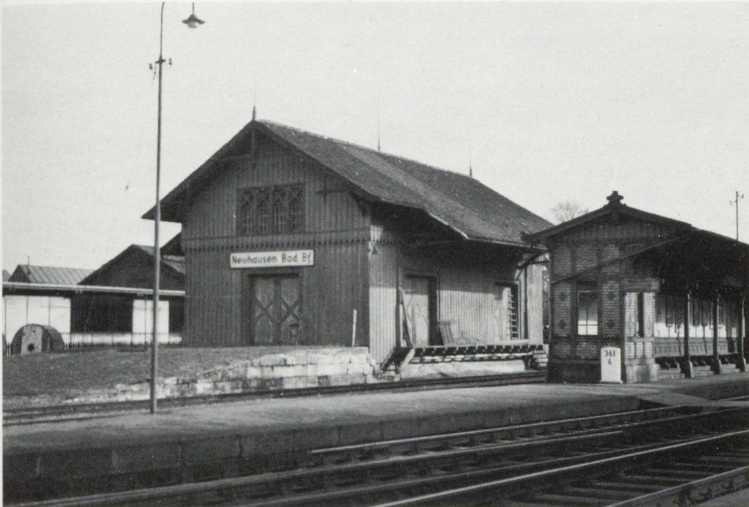
Abb. 2 Der Güterschuppen und die nördliche «Schirmhalle» auf dem Badischen Bahnhof in Neuhausen am Rheinfall. Aufnahme aus dem Jahre 1961 von Hermann Werner (1896–1975). (Staatsarchiv Schaffhausen)
