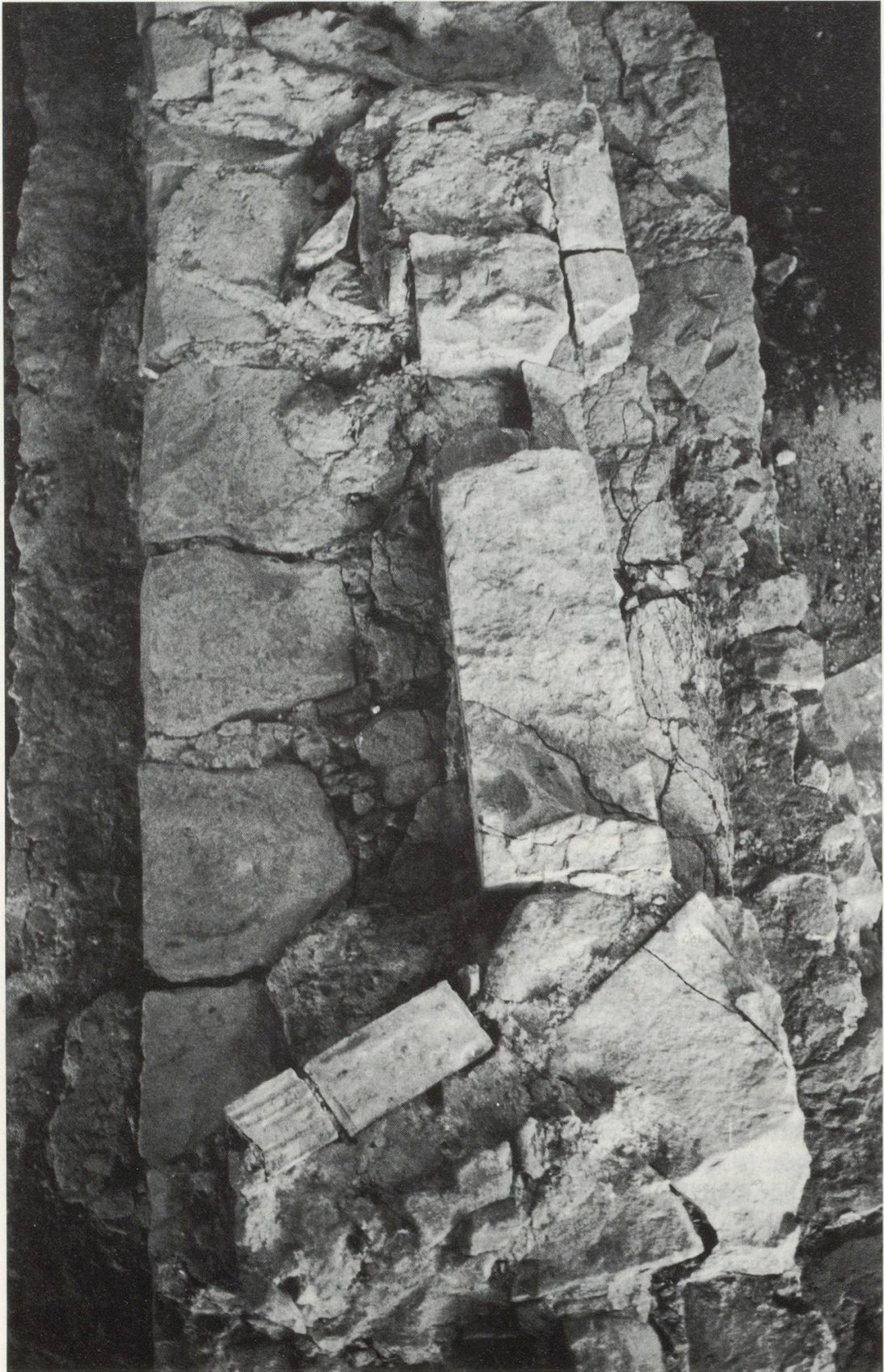
Abb. 8 Türschwelle der 1598 abgetragenen südlichen Langhausmauer.
