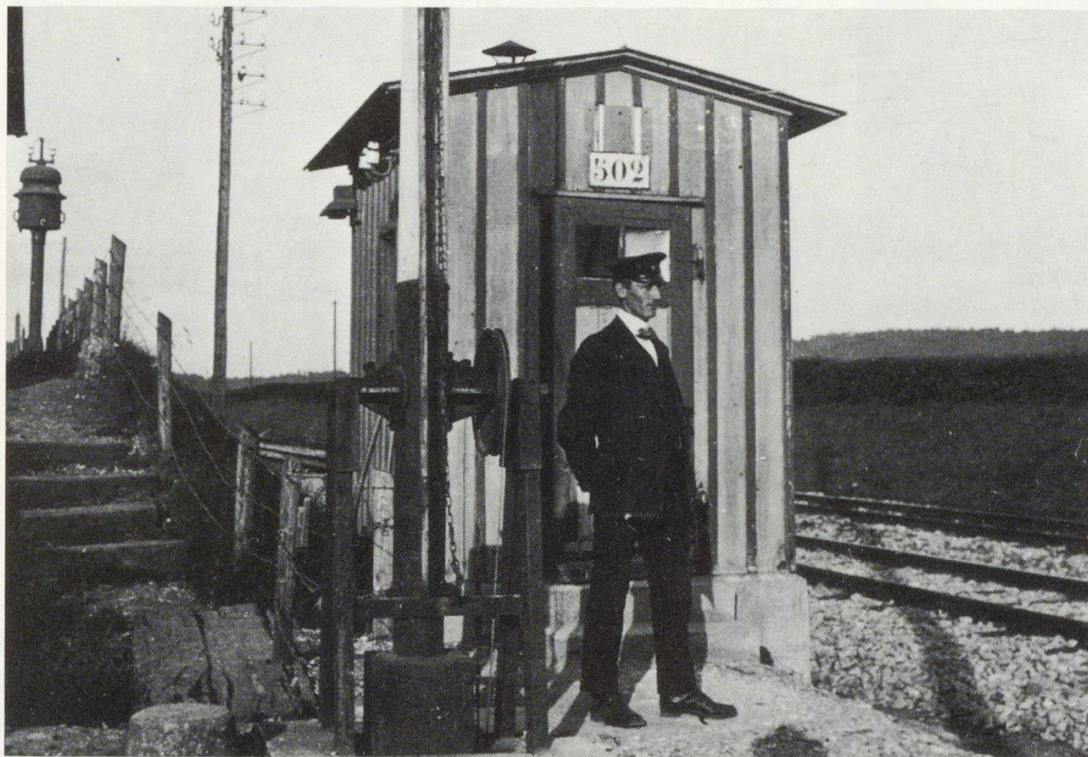
Abb. 3 Heinrich Bollinger (1895–1978) aus Beringen, der es im Dienste der Deutschen Reichsbahn und der Deutschen Bundesbahn bis zum Oberbahnwart brachte, beim «Wachthäuschen» der «Bahnwart-Station» Nr. 502 am Guntmadingerweg. Wie Heinrich Bollinger standen viele Schaffhauser – manchmal über Generationen – im Dienste der Grossherzoglich Badischen Bahn, der Deutschen Reichsbahn und der Deutschen Bundesbahn. (Aufnahme im Besitze von Herrn G. Bollinger, Beringen)
