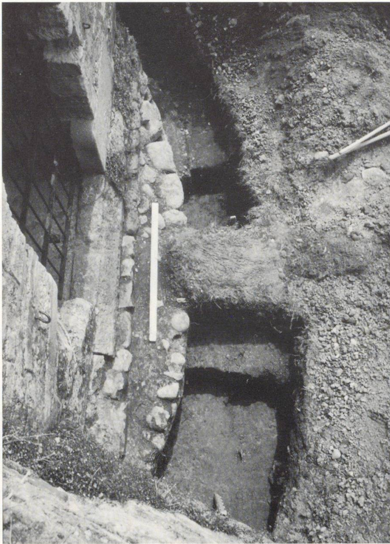
Abb. 34 Stein am Rhein, Auf Burg. Blick auf das runde Fundament des Südostturmes. Auf diesem Fundament Reste der einen Seitenfläche des im Plan auf einem regelmässigen Siebeneck basierenden Turmes.
