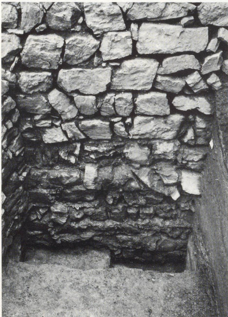
Abb. 4 Der Fundamentbereich der Stadtmauer des mittleren 13. Jahrhunderts.
