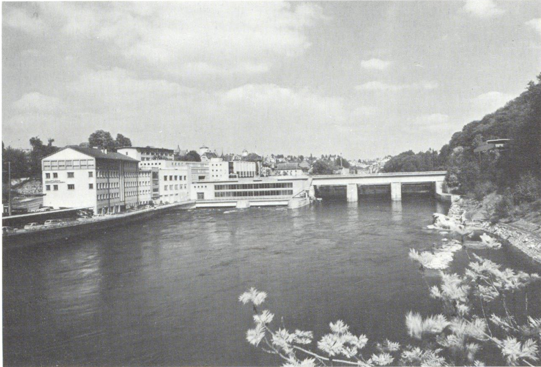
Das heutige Kraftwerk Schaffhausen, Sicht vom Unterwasser
