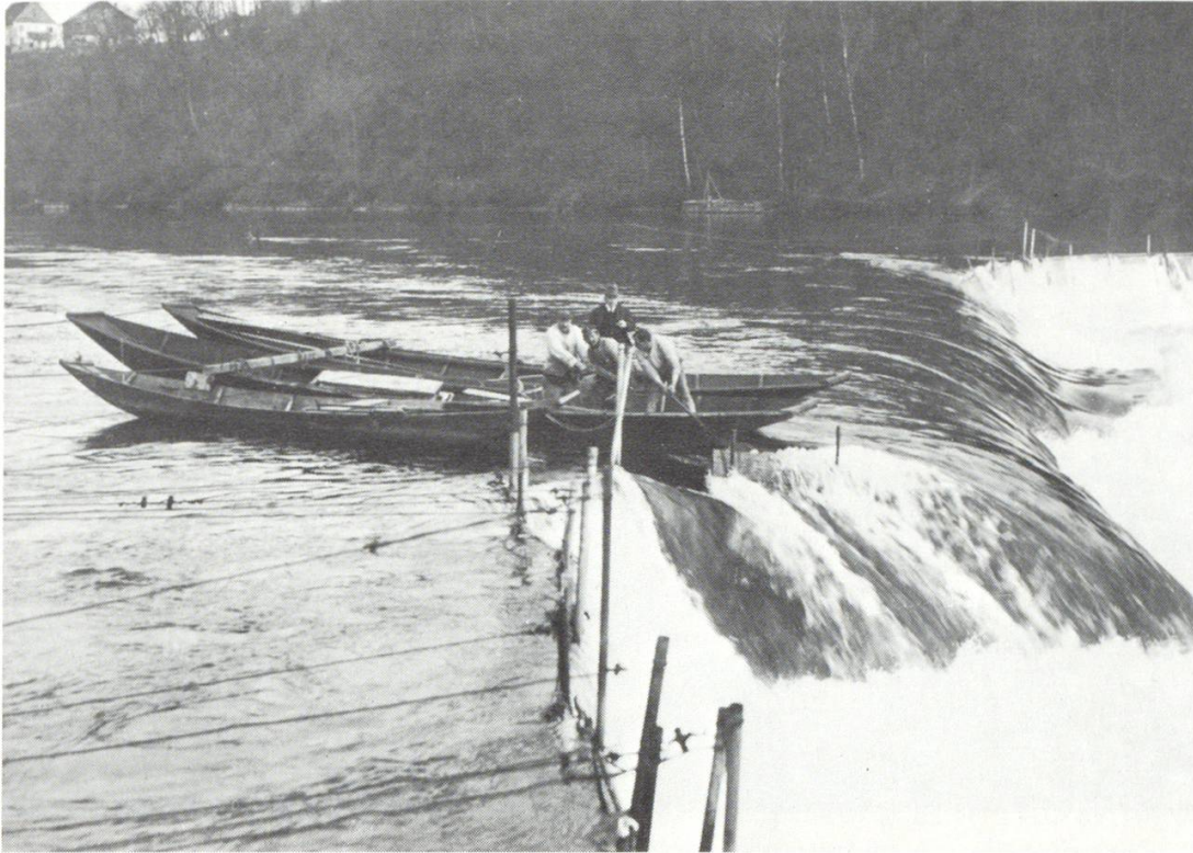
Stauarbeiten am Moserdamm (bis 1960)
