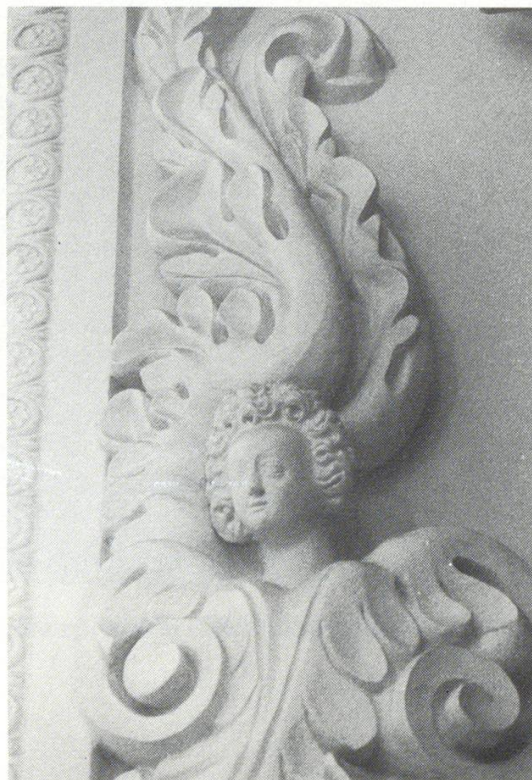
Abb. 14 Luzern, Jesuitenkirche. Detail der Fensterrahmung in der vierten Seitenkapelle
