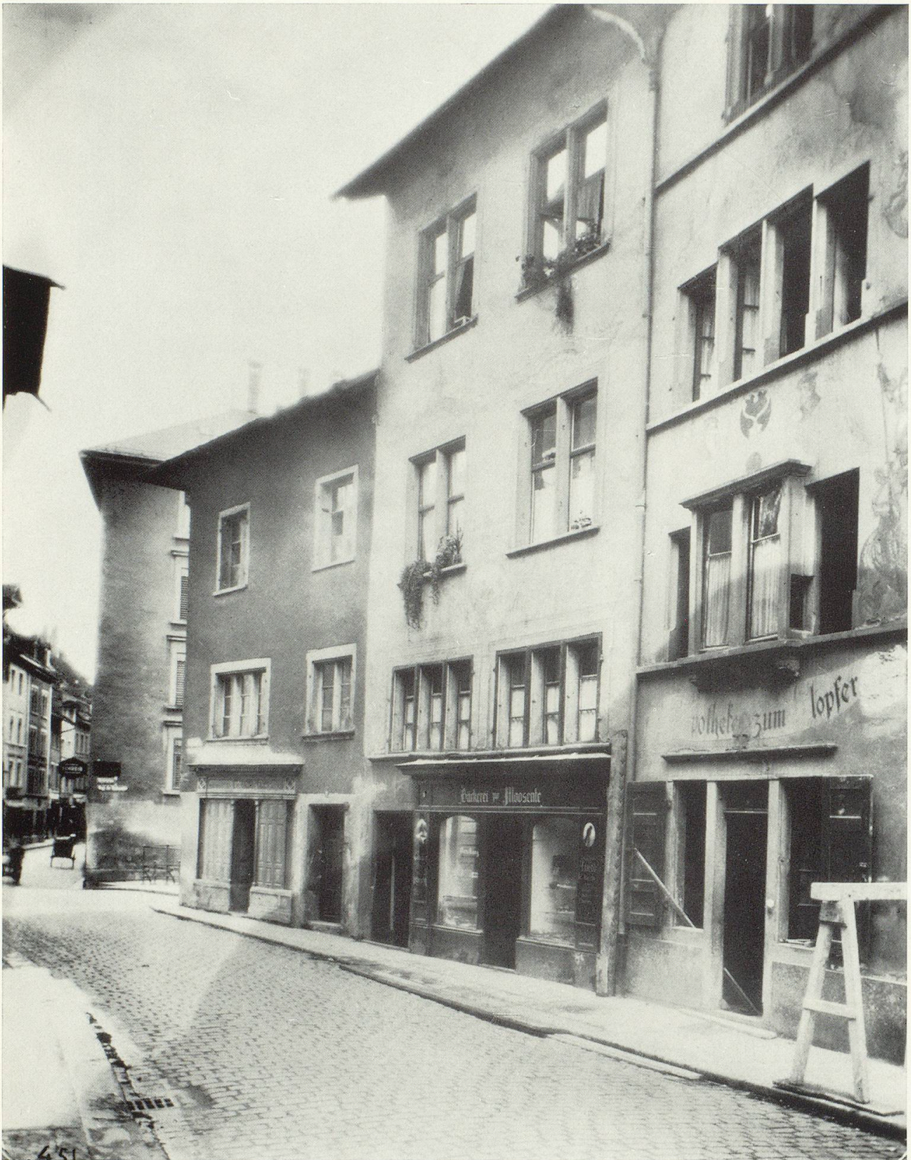
«Klopfer» (links «Moosente» und «Bachbrücke») während des Umbaus von 1930 (Fotosammlung Stadtarchiv)
