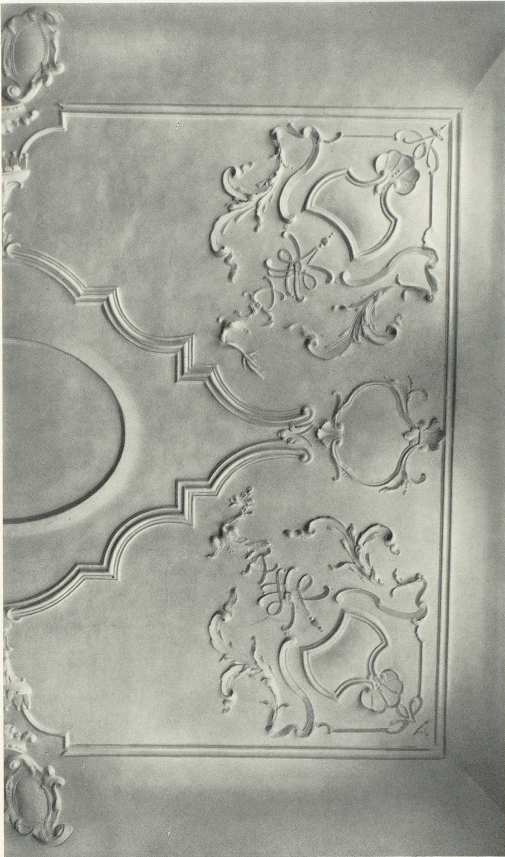
Decke im ersten Obergeschoss des Hauses zum Löwenberg (südliche Hälfte)
