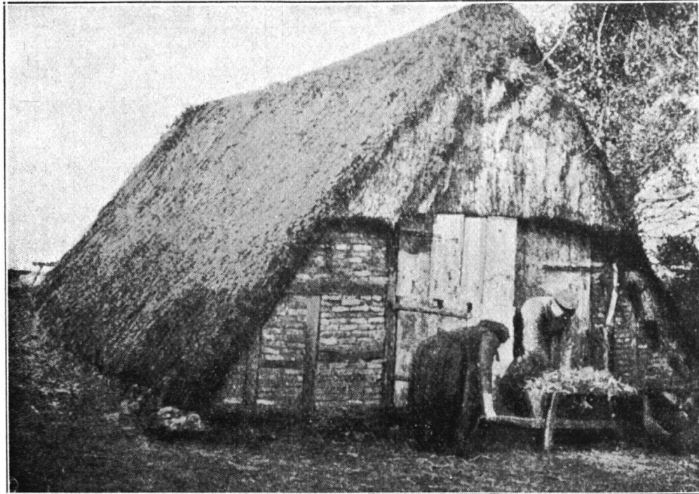
Fig. 1. Dachhütte, Lüneburger Heide (Aufnahme Ranck)
