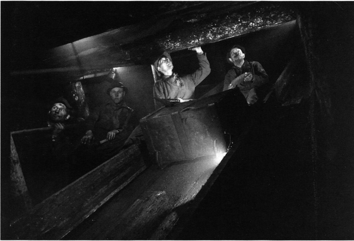
Materialaufzug in einem Gesenk
