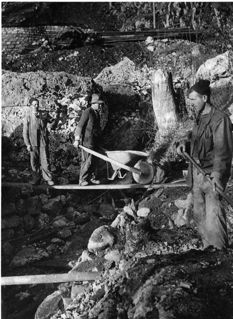
Planierungs- und Sicherungsarbeiten beim Klusbach
