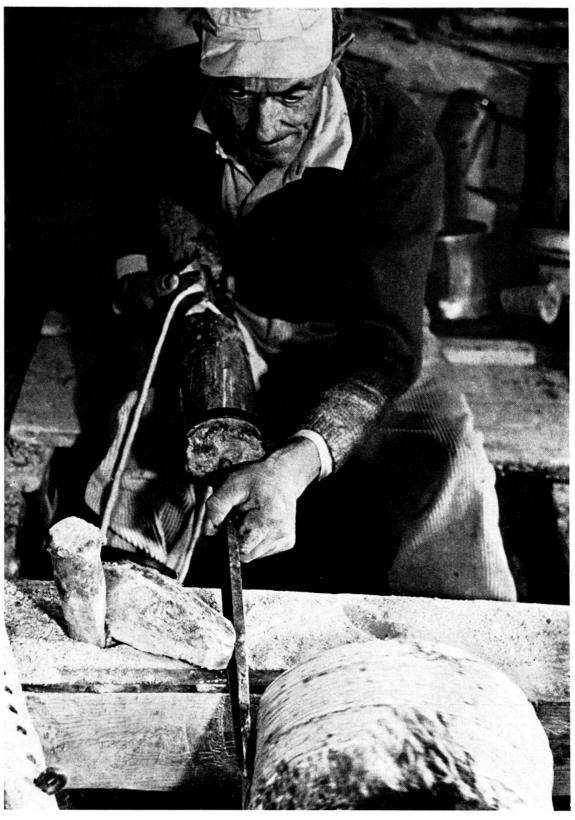
Abb. 5. Der Lavezdreher beim Überdrehen der Aussenseite eines Rohlings. Im Vordergrund der rotierende Rohling, dahiner der Querbalken. In diesem steckt ein Zapfen, an welchen ein Holzstück angelegt ist, um so dem Werkzeug Halt und Führung zu geben. Das schwere Werkzeug hält der Dreher mit den Händen und klemmt es unter den Arm. In einer der Kerben ist die Seilschlinge eingehängt. Man beachte auch die Konzentration auf dem Gesicht des Drehers.
