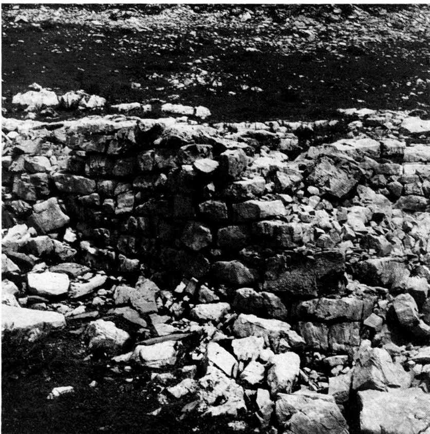
Abb. 4 Reste einer sorgfältig aufge- bauten Trocken- mauer. Muotathal SZ, Charetalp, Graben, 1858 m.
