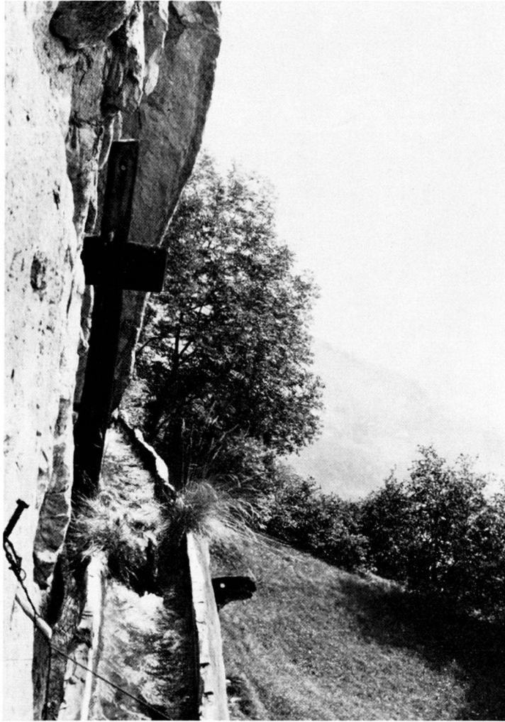
Abb. 7. Wasserkännel an einer Felswand. Oben im Fels befestigtes Tragholz. Darin befestigt der eigentliche Kännelträger. Vorn neuere Reparatur mit Eisenstab und Drahtseil.
