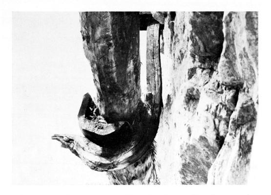
Abb. 8. Gleicher Kännel von unten: Es ist der gebogene Kännelträger sichtbar.
