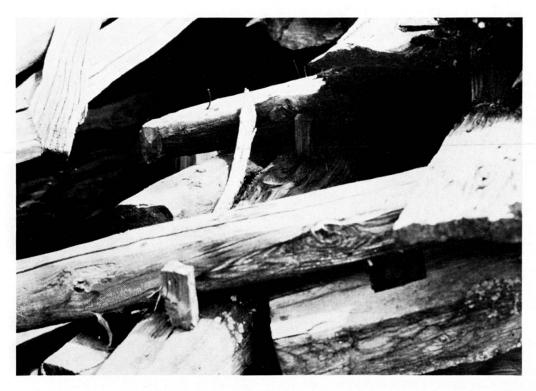
Abb. 2. Eingestürztes Dach, bei dem man die Zapfen zur Fixierung der Latten sieht.
