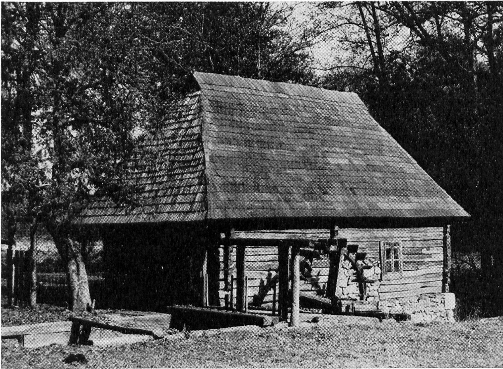
Fig. 2. Mühle mit senkrechtstehendem, unterschlächtigen Wasserrad aus Dăbâca, Region Hunedoara.
