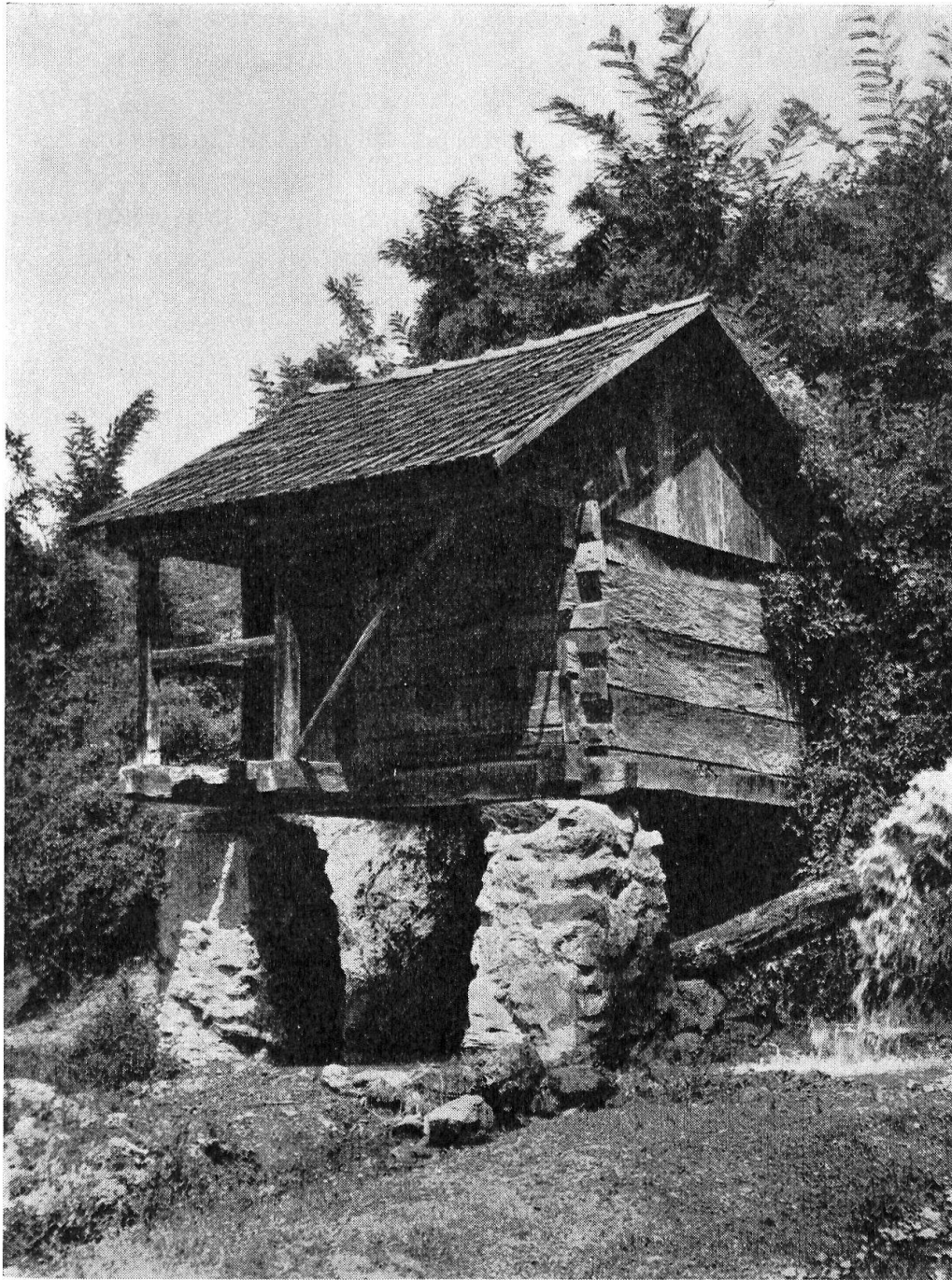
Fig. 1. Löffelradmühle aus Topleț, Rayon Orșova, Region Banat.
