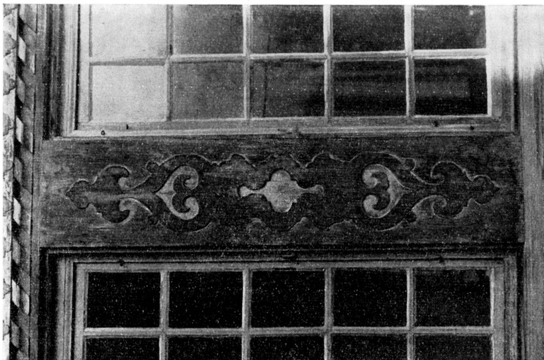
Fig. 5. Grand Chalet, Rossinière, 1754. Meneau de fenêtre.
