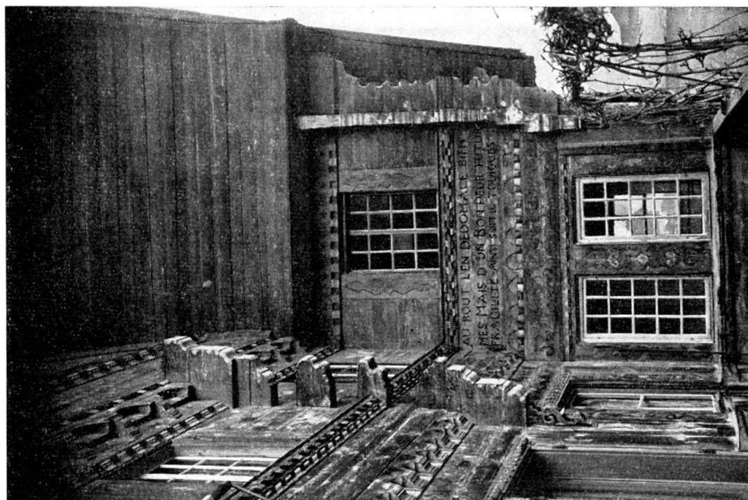
Fig. 4. Grand Chalet, Rossinière, 1754. Cabinet de travail et profil des têtes de poutres.
