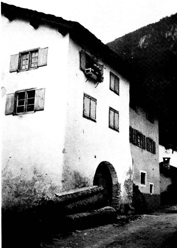
Abb. 30. Charakteristische Lage der Stube im ersten Stock über der Einfahrt in den Häusern Mittelbündens. Haus in Ziraun (Schams).
