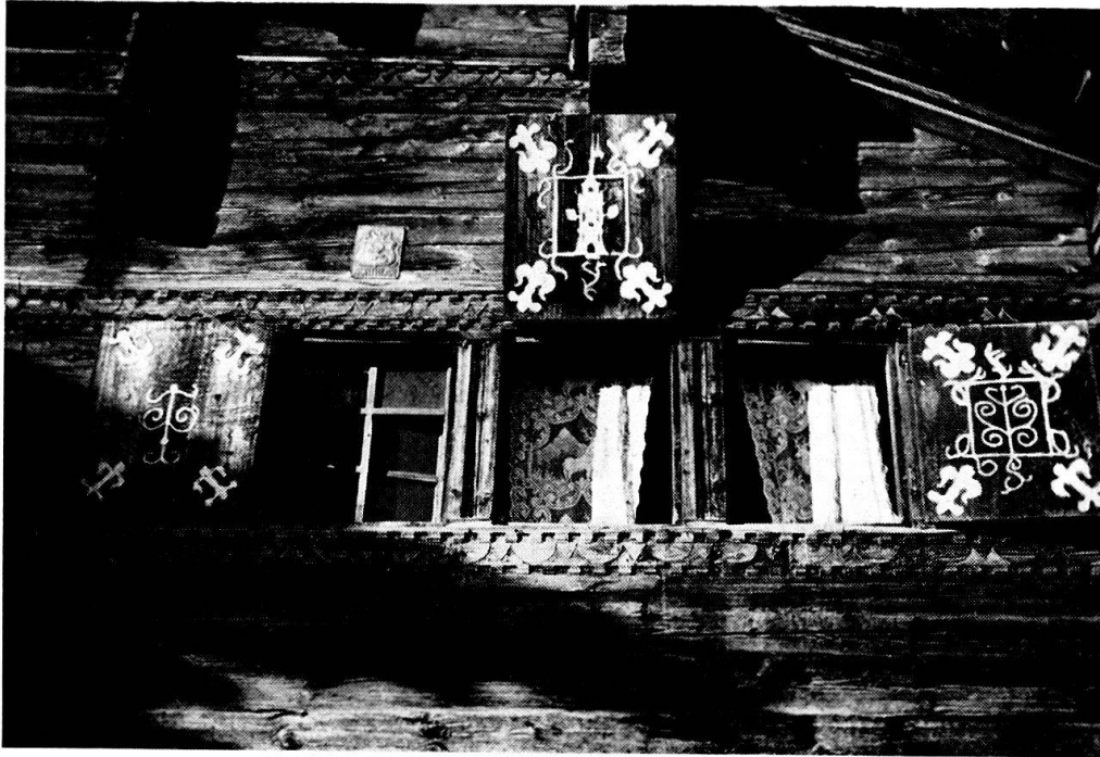
Abb. 33. Stubenfenster an einem Doppelhaus in Vrin. Verzierte Simsbalken und auf der Innenseite bemalte Fensterläden.
