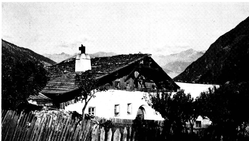
Abb. 24. Massiver Kamin mit eingelassenem, als Wetterfahne funktionierendem Eisenrohr in Tubre. Alto Adige.
