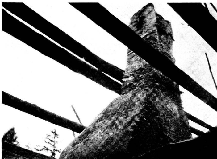
Abb. 22. Gemauerter Kamin auf Trägern mit trichterförmiger Ausweitung nach unten (Rauchfang), während eines Abbruchs aufgenommen in Sporz (Obervaz).
