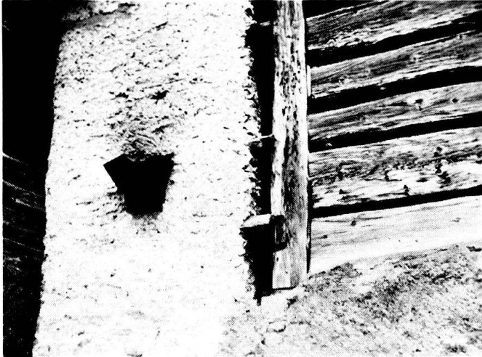
Abb. 18. Rauchloch in der Mauer beim Maisäss Acla Palpuogna (Bravuogn).
