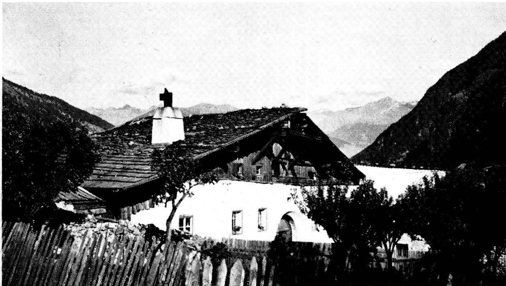
Abb. 24. Massiver Kamin mit eingelassenem, als Wetterfahne funktionierendem Eisenrohr n Tubre. Alto Adige.
