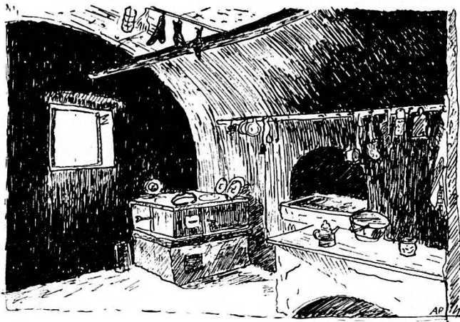
Abb. 14. Alte Küche cuschina in Fuldera (Val Müstair). Eiserner Aufsatzherd platta auf der ursprünglichen steinernen Herdplatte, Backtrog mit Holzdeckel und an der Decke Stangen zum Aufhängen des Dörrfleisches. Der Schüttstein in der Nische des Backofens ist neu.
