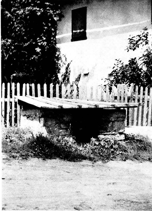
Abb. 9. Feuerstelle im Freien fueina giuadó in Castrisch; dient für die grosse Wäsche und zum Abkochen von Schweine- futter. Aufklappbares Bretter- dach.
