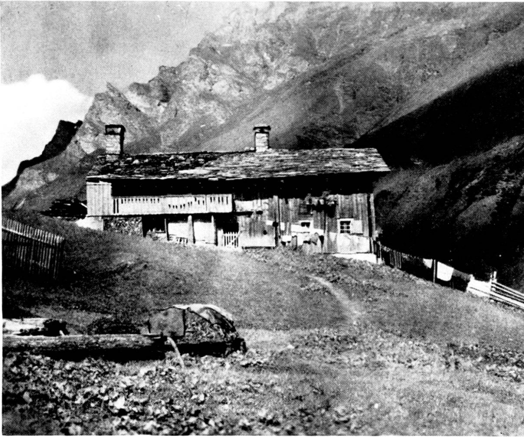
Haus mit Verschalung und Plattendach (17. Jahrhdt.) Thalkirch
