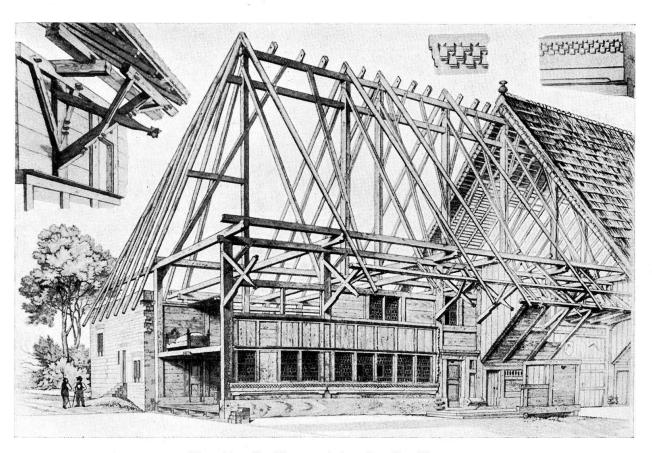
Fig. 11. Dachkonstruktion der Strohhütte
