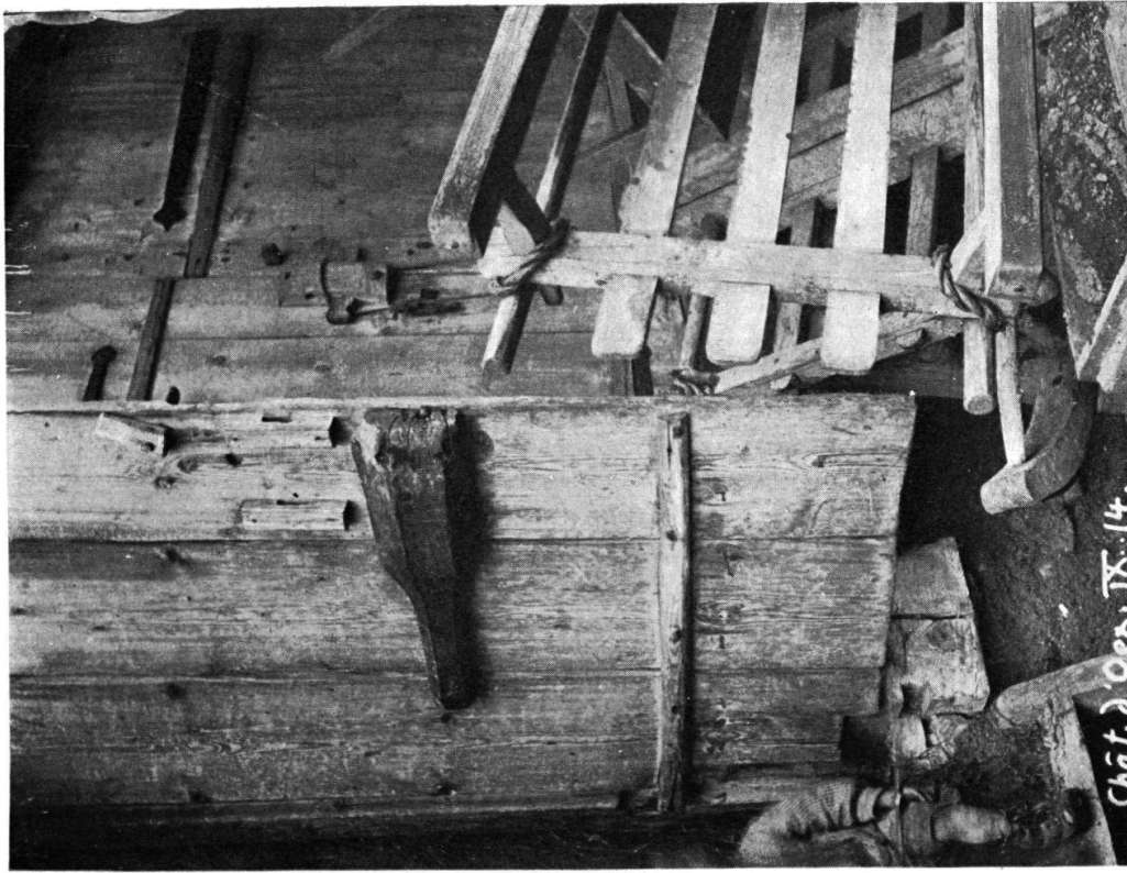
Portes de granges à Château-d'Oex montrant 4 types de serrures réunis: bouton à chrochet, verrou à encoches, serrure à chevilles et sépon.
