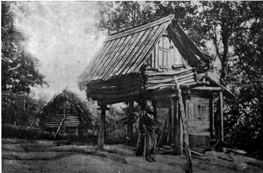
50. Pfahlbau-Speicher mit Kerbbalkentreppe. Riontal, Kaukasus.
