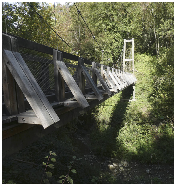
Fig. 5: Passerelle pédestre au-dessus du Nant du Longet.
