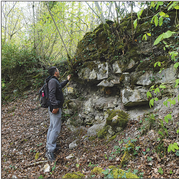
Figure 64 : Digue de retenue du bassin d'accumulation des moulins Dufour.
