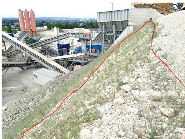
Figure 10. Etat de la végétation du site B.1, 2 mois après travaux.
