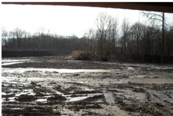
Les Douves, dans les bois de Versoix, site à la fin des travaux en 2009
