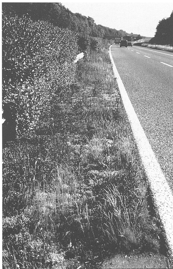
Figure 6 : Berme centrale pionnière au km 23 (Coppet VD, juin 2003).
