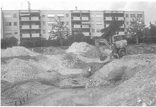
Site de l'UICN pendant les travaux. Photo : F. Meier.
