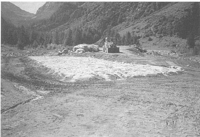
2. Mise en place de la chaux stabilisée.
