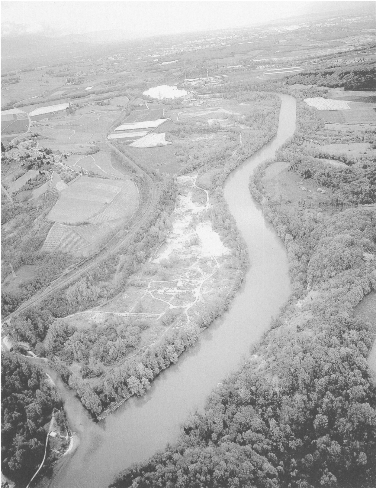
Figure 2. Vue générale des Teppes-de-Véré et du Biolay, en direction du nord-est. Au premier plan, à gauche: l'embouchure de l'Allondon dans le Rhône et la zone dite «vers Cinge». Au second plan, les Teppes-de-Véré et du Biolay, bordées à gauche par la voie de chemin de fer; en face, sur l'autre rive du Rhône, le Moulin-de-Vert. En arrière plan, l'usine d'incinération de Verbois
