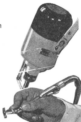
elektrische Zahnbohrmaschine zum Fräsen, Schleifen, Polieren und Spalten
