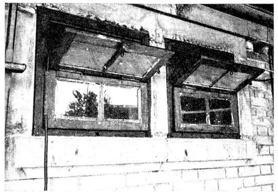
Abb. 25 Rinderversuchsstall Sch. in L., defekter Fensterrahmen.
