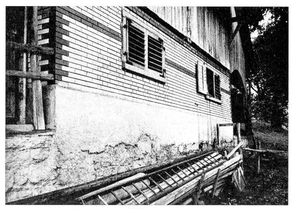
Abb. 24 Rinderversuchsstall W. in R., talseitige defekte Stallmauer.
