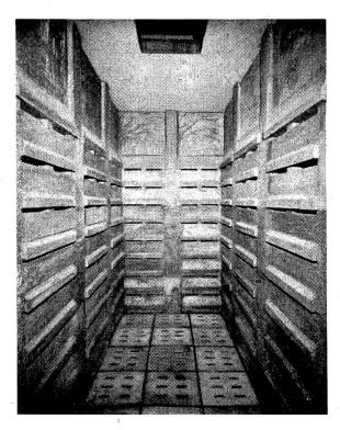
Inneres einer Beccari-Zelle. Oben das Einwurfloch. Boden- und Seitenflächen mit Betonplatten eingefaßt.
