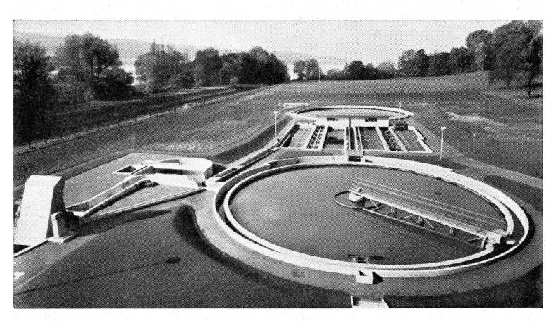
Abb. 1<sup>1</sup>. Mechanisch-biologische Kläranlage von Uster: Im Vordergrund: Klärbecken mit langsam sich drehendem, zeigerartigem Ölfang; dahinter erkennt man die doppelt angelegten Belebtschlammbecken (mit Metallbürsten) und ganz zu hinterst das Nachklärbecken.
