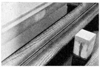
Abb. 4. Rotierende Metallbürste des Belebtschlammverfahrens.
