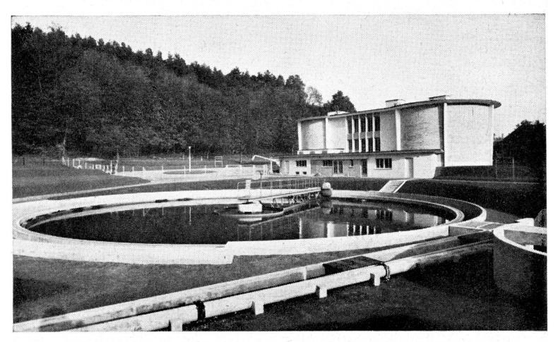
Abb. 2. Vorklärbecken, Schlammfaultürme.
