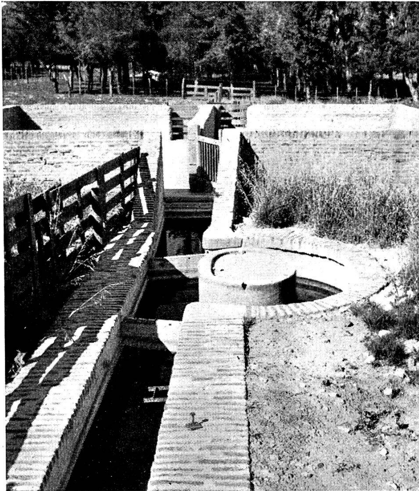
Abb. 14. Räudebad für Schafe. Das eingebaute Rundbassin ermöglicht, die Dauer des Bades zu dosieren.
