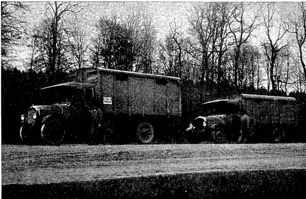
Seuchencamion des eidgen. Veterinärarnantes. Fassungsvermögen 8 bis 10 Stück Großvieh, d. h. ungefähr das gleiche wie ein mittlerer Eisenbahnwagen.
