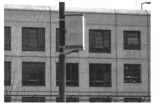
Dieses System wird in der JVA Gelsenkirchen (D) betrieben. Eine Antenne auf dem Gefängnisgelände, welche auf die Zellenfenster gerichtet ist, erkennt die Funkwellen und leitet die Information an den Computer der Sicherheitszentrale weiter (nur Detektion). Die Anlage ist
