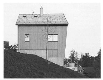
steht der Neubau doch ausserhalb der Bauzone. Unter anderem war das Gebäudevolumen beizubehalten, ein massives Sockelgeschoss samt Holzaufbau umzusetzen, die ortstypische Täferfassade aufzugreifen und eine angemessene Einbettung ins Terrain zu gewährleisten.
