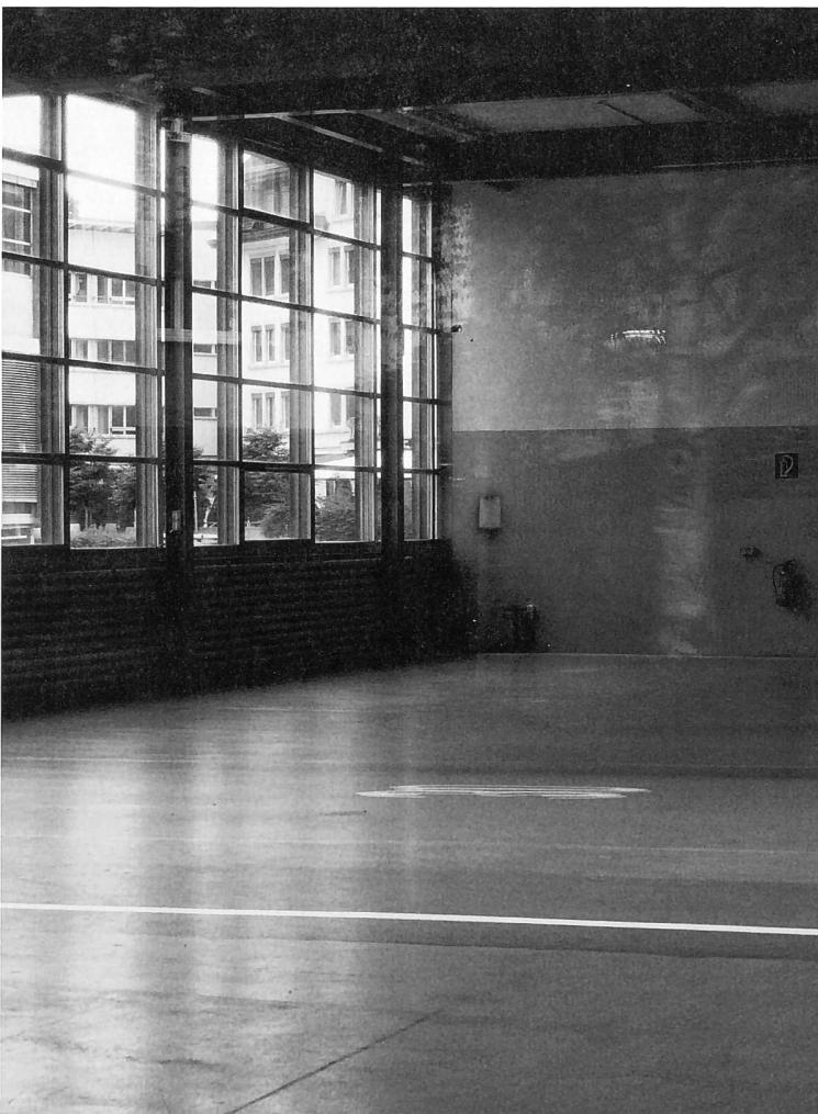
und Bürotrakt in Massivbauweise. Statisch war das eine Herausforderung, denn unter den Wohneinheiten befindet sich eine zweigeschossige Werkhalle, die in die Montagehalle übergeht – beide ohne tragende Pfeiler.
