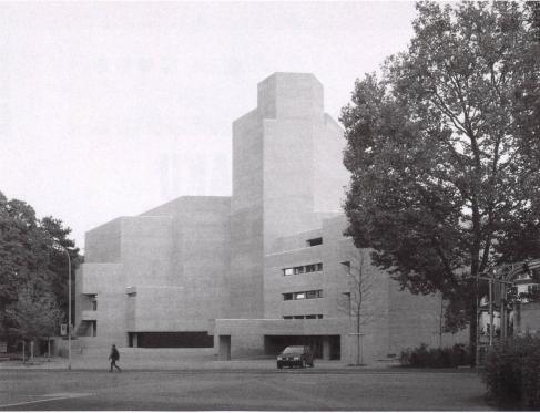
Aufgabe, da der Beton seinerzeit von Hand Der Sichtbeton wurde relativ zurückhaltend bearbeitet. Der Poren-Lunker-Verschluss wurde abgetragen, schadhafte Stellen darunter vor Ort gemischt wurde und dementspre- lediglich repariert. Um dem gesamten Bau ein möglichst einheitliches Bild zu geben, behandelte man die Erweiterung anschliessend mit einer Lasur aus Steinmehl.
