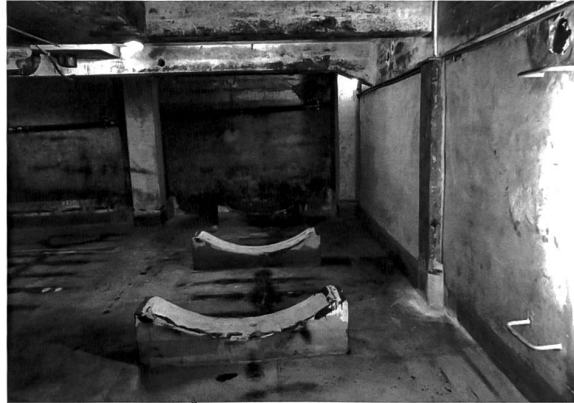
Einer der ehemaligen Öltank-Keller. (Bild: Su.)
