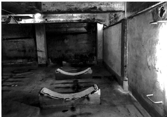
Einer der ehemaligen Öltank-Keller. (Bild: Su.)
