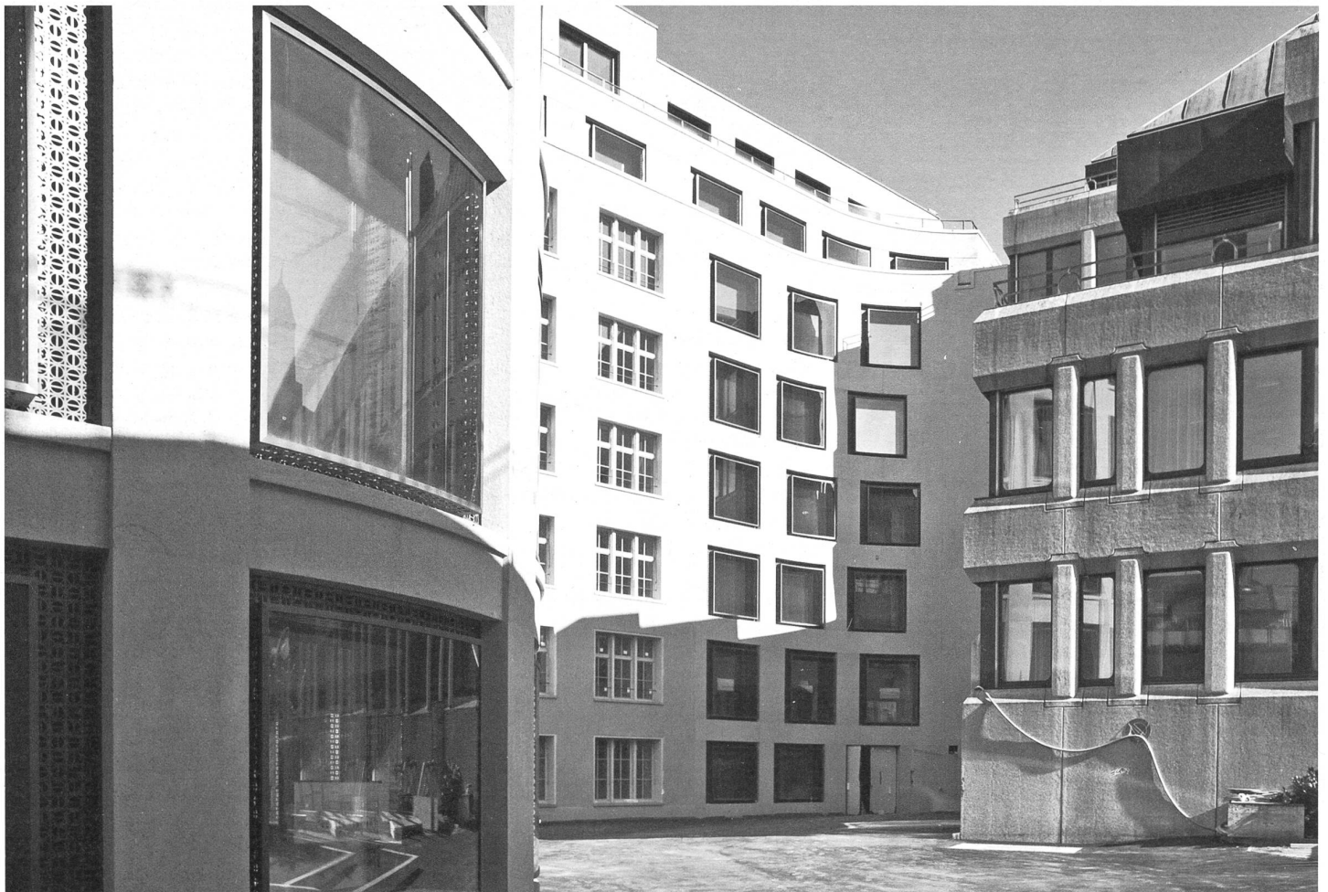
Gut eingefügt: das Verwaltungsgebäude von Jessen Vollenweider, Ansicht von hinten, rechts das alte UBS-Gebäude. Bild: Marko Sauer
