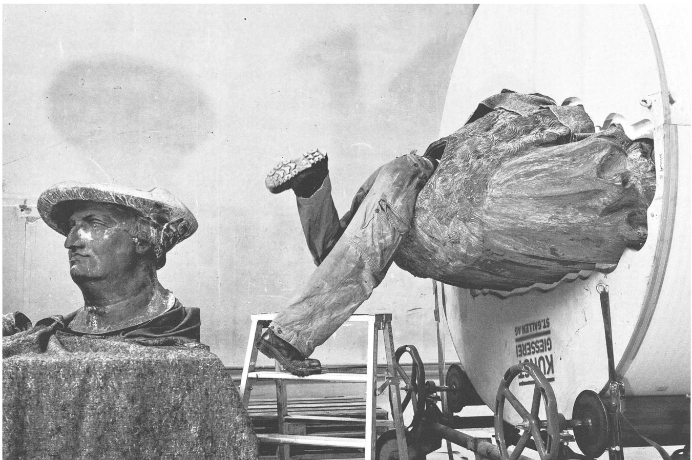
Vadians Körper liegt kopflos in Styropor, so dass er um seine Achse gedreht und der Beton in seinen Beinen rausgespitzt werden kann. Dieser ist verantwortlich für die Risse in der Statue des St.Galler Stadtvaters. Neu werden inwendig Metallverstrebungen für seine Stabilität sorgen. Eine solche Massnahme könnte eventuell auch dem aktuellen Stadtrat auf die Beine helfen.
