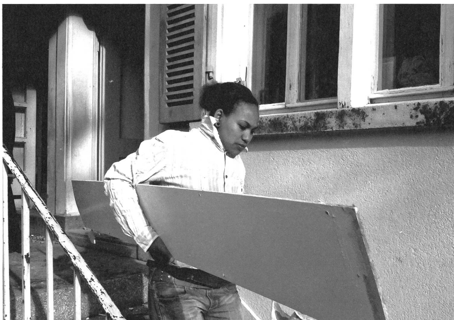
Mit Freiwilligenarbeit vorwärts: Beim Umbau des Solidaritätshauses.
