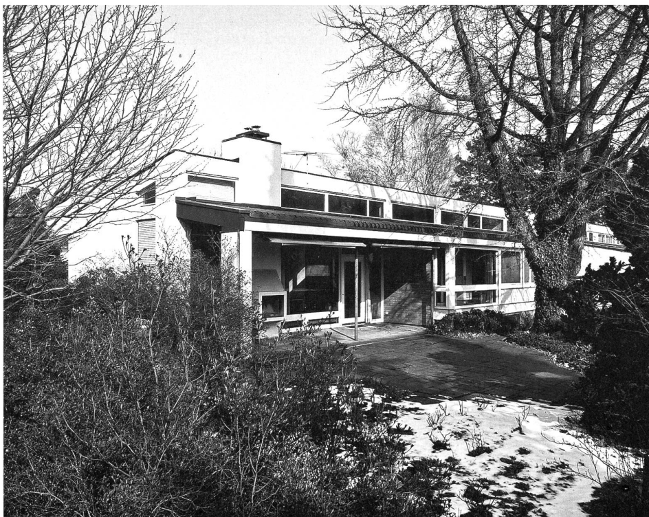
Villa Stoffel in Au: Sie wurde gerettet und nun sind Käufer gesucht.
