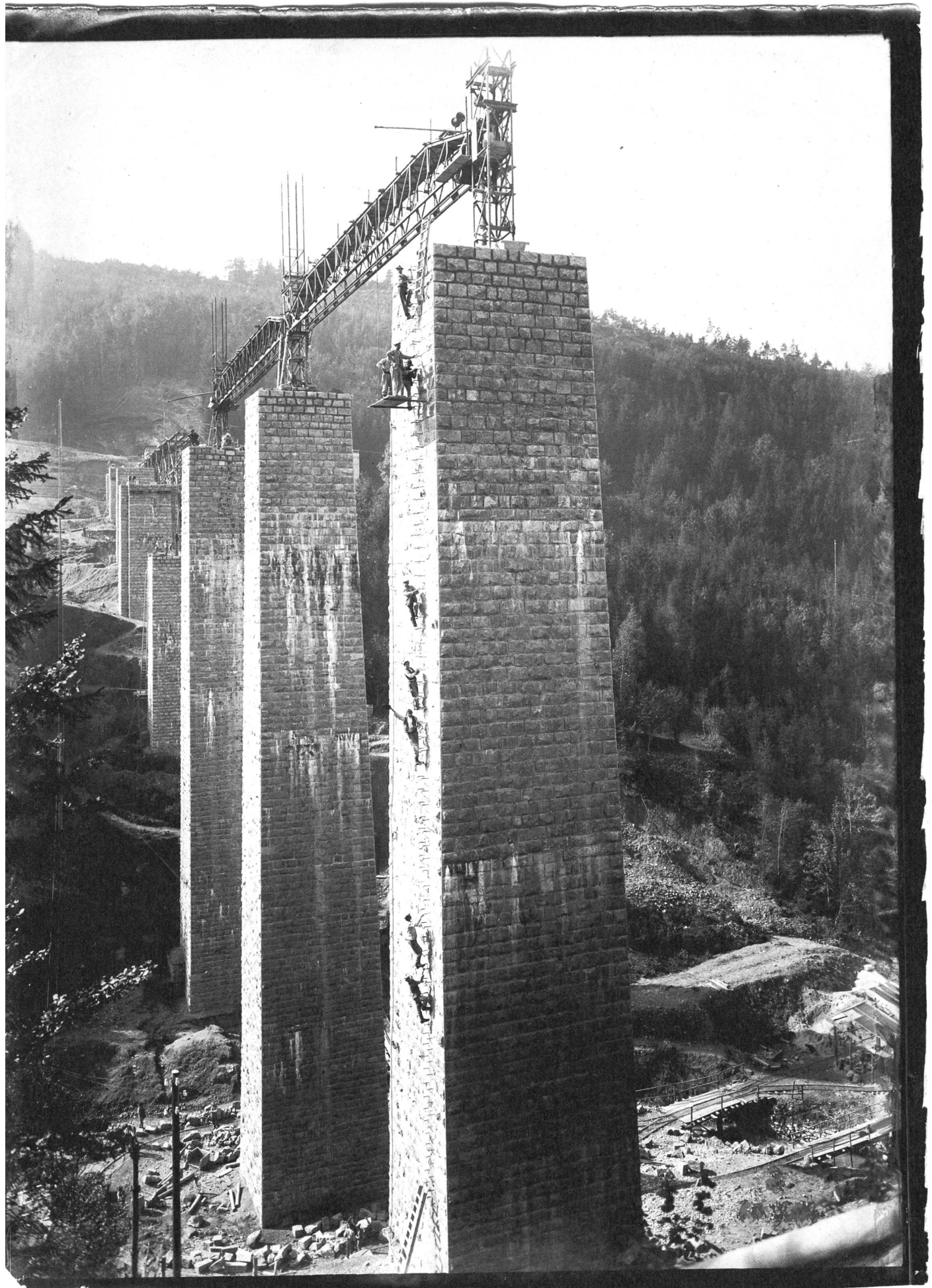
Nicht ganz Suva-gerechtes Bauen am Wissenbachviadukt.
