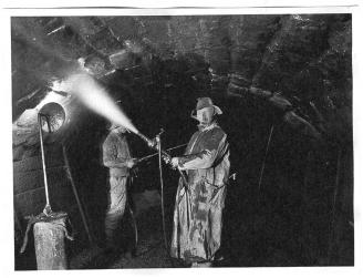
Ein Tunnelarbeiter «wäscht» das Mauerwerk mit einem Sandstrahlgebläse.
