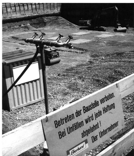
In Winterthur wird fröhlich weitergebaut. Bild: Manuel Lehmann
